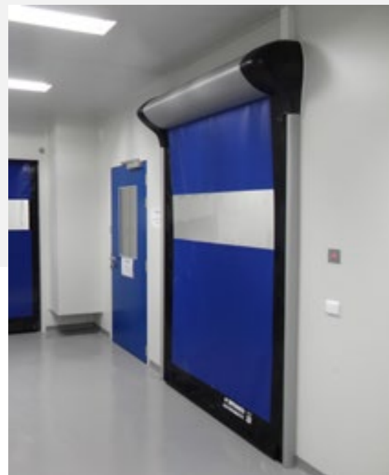
Porta avvolgibile ermetica adatta per ambienti ISO 7 (in conformità ISO 14644 -14)
