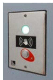
Indicatore luminoso con sistema d'apertura a microonde senza contatto con pulsante d'emergenza
